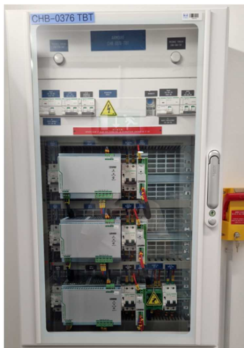
Figure 1 – Solution plastron transparent sur équipements fixés en fond d'armoire
